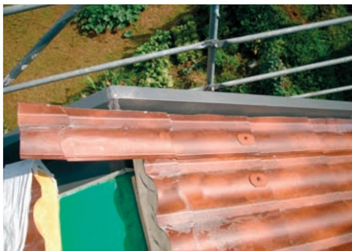
**13.** Nel caso si verifichi la necessità di tagliare i pannelli bisogna proteggere la superficie interessata al taglio con nastro adesivo; tracciare sul nastro con pennarello il taglio da eseguire; eseguire il taglio con seghetto alternativo; pulire la superficie dalle scorie create durante la fase di taglio per evitare fenomeni di corrosione; togliere il nastro adesivo.
