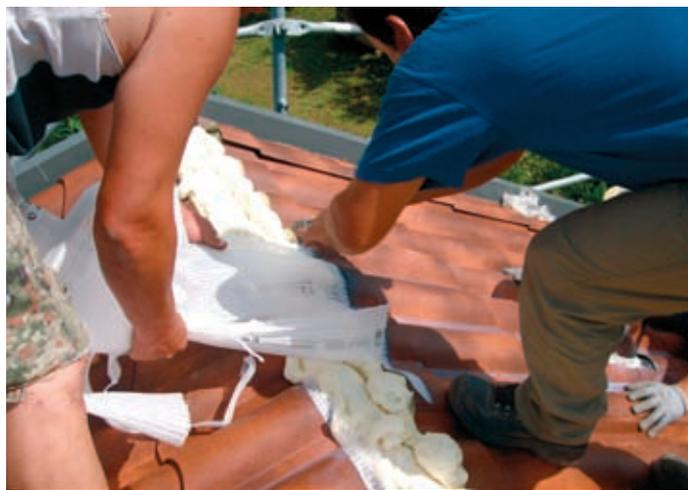
**18.** Per ottenere una buona resistenza alle infiltrazioni meteoriche, in particolare nelle condizioni di contemporaneità di pioggia intensa e forte vento normale alla falda, è opportuno risvoltare verso l'alto dalla parte del colmo una porzione di lamiera di circa 4 cm del supporto esterno nel tratto compreso tra le greche.
