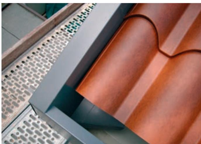
**16.** Posa delle eventuali successive file di lastre sormontanti la prima di gronda, realizzando una sovrapposizione come sopra descritta, verificandone l'allineamento.
